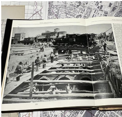
La costruzione dei canali
