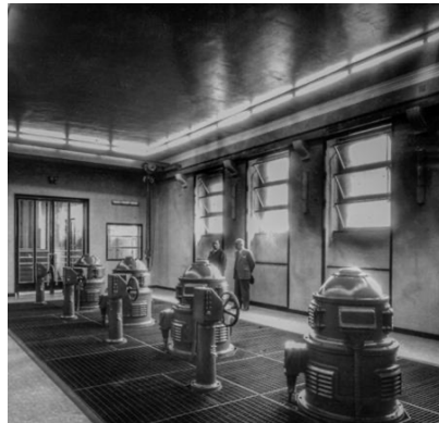
La Centrale nel 1948
